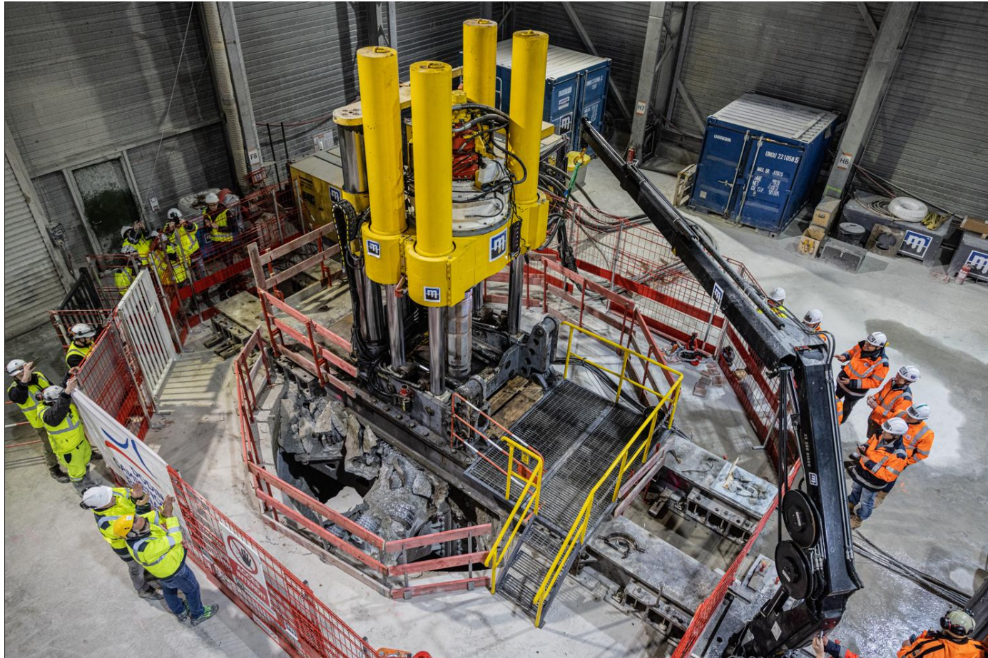
Ing. L. Brino- AXEL (Autonomous Exploration Electrified Vehicle), l' <<esploratore>> telecomandato del cunicolo geognostico della Maddalena
