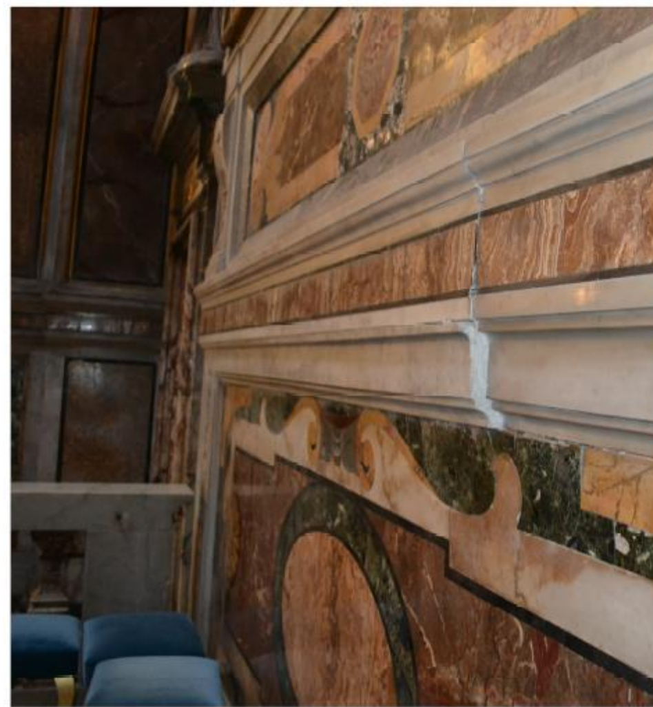
Spanciamento della parete
