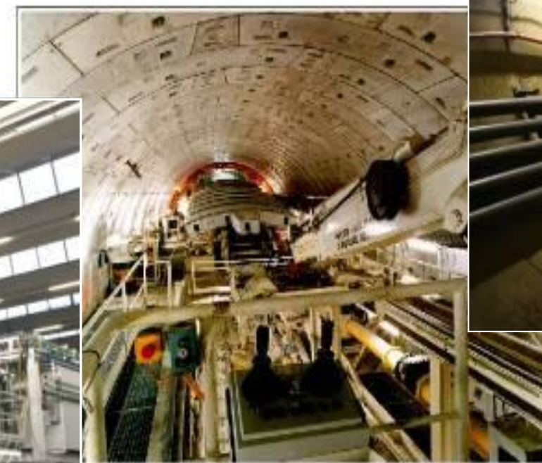
NASTRO TRASPORTATORE E GRU PER CONCI PREFABBRICATI
