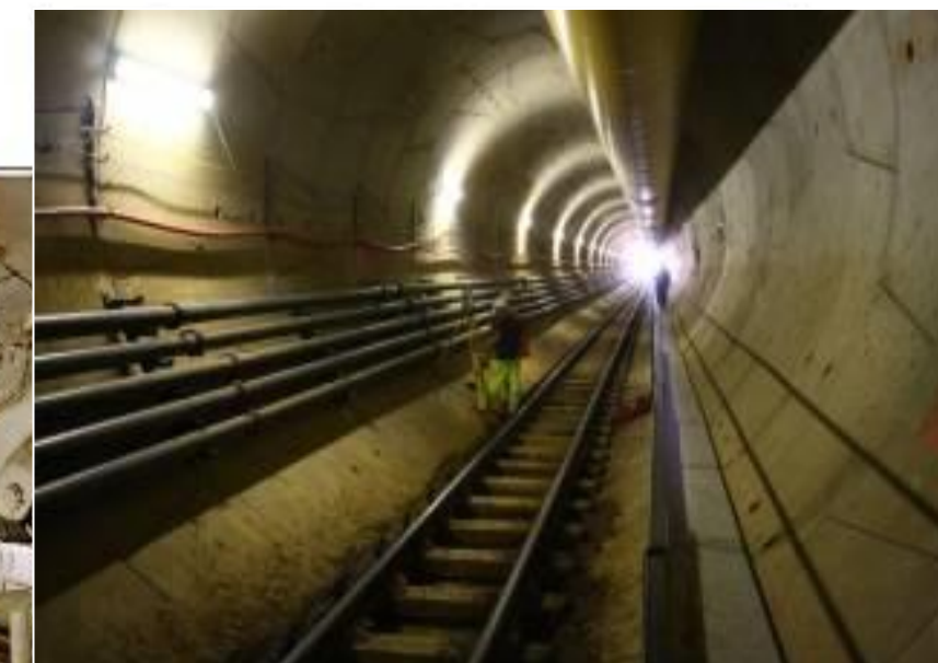
RIVESTIMENTO IN CONCI PREFABBRICATI
