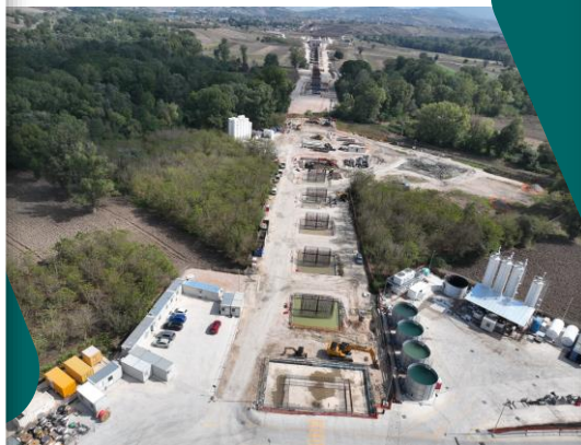
VI01 – Viadotto Hirpinia
